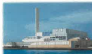
工場の新設・長寿命化工事
