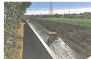
土砂流出防止対策／都筑区
